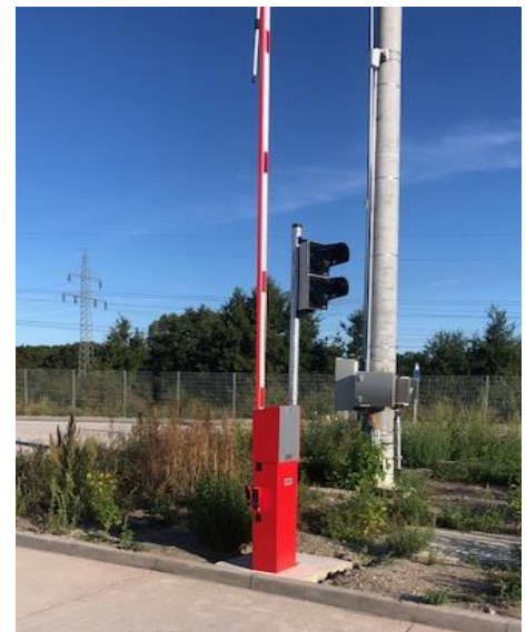
Bild 3: Schrankenanlage inkl. Sprechsäule
