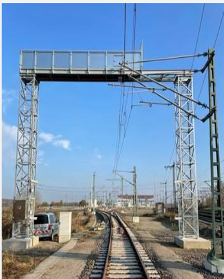
Bild 1: Videotor Schiene, begehbares Portal
